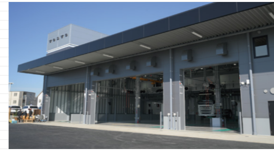
▲サービス工場側から見た店舗全景。工場前のシャッターは車両の入出庫時以外は閉め、近隣住宅への騒音低減と冷暖房効率向上を両立
