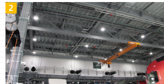
▲天井走行クレーン(上)の設置に合わせて各整備ストール間に“自立式リール架台”を採用。クレーンを最大限活用できるレイアウト
